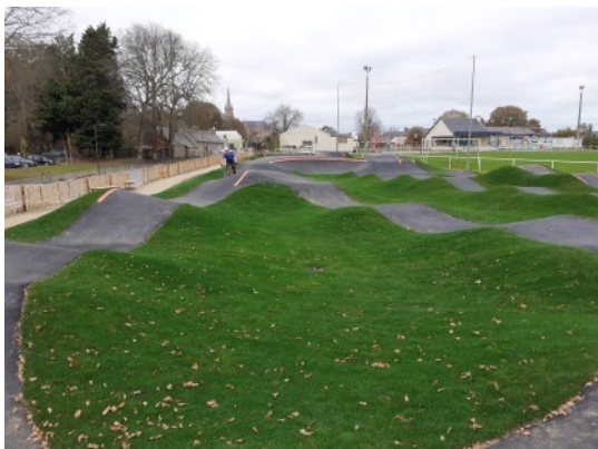
Pommeret – création d'un pumptrack
